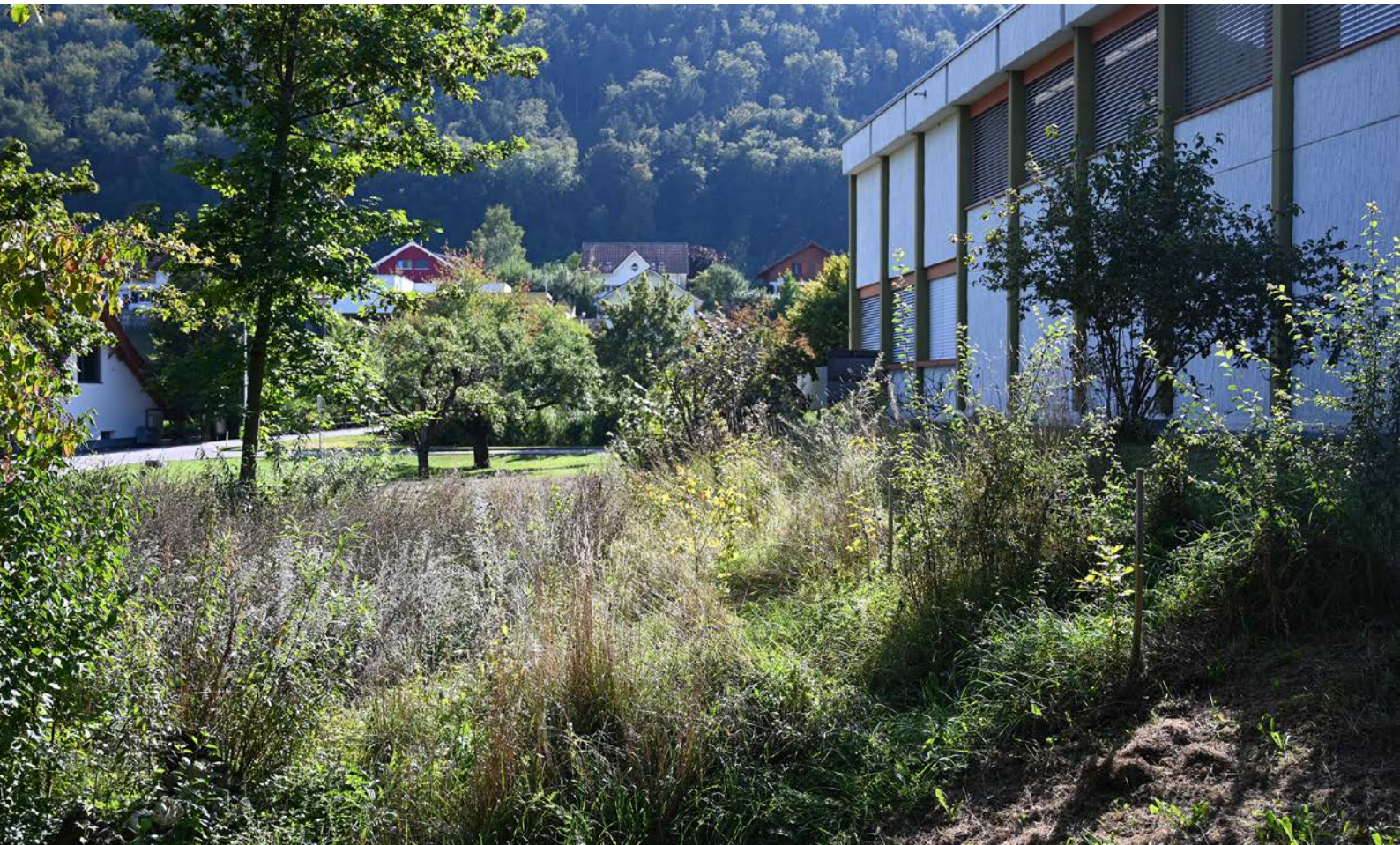
Beim Schulhaus Brühl in Mümliswil (SO) erhält die Natur mehr Platz.
